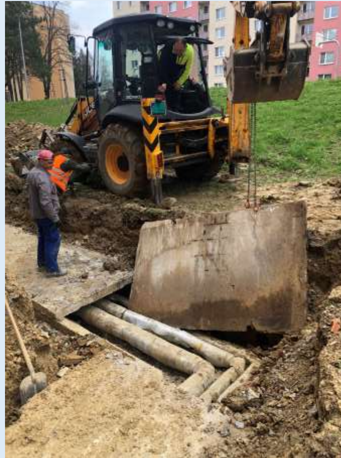
Odkryvanie pôvodných potrubí
