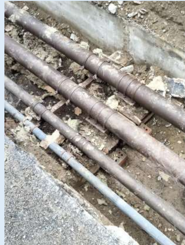
Pôvodne potrubie (odizolované)
