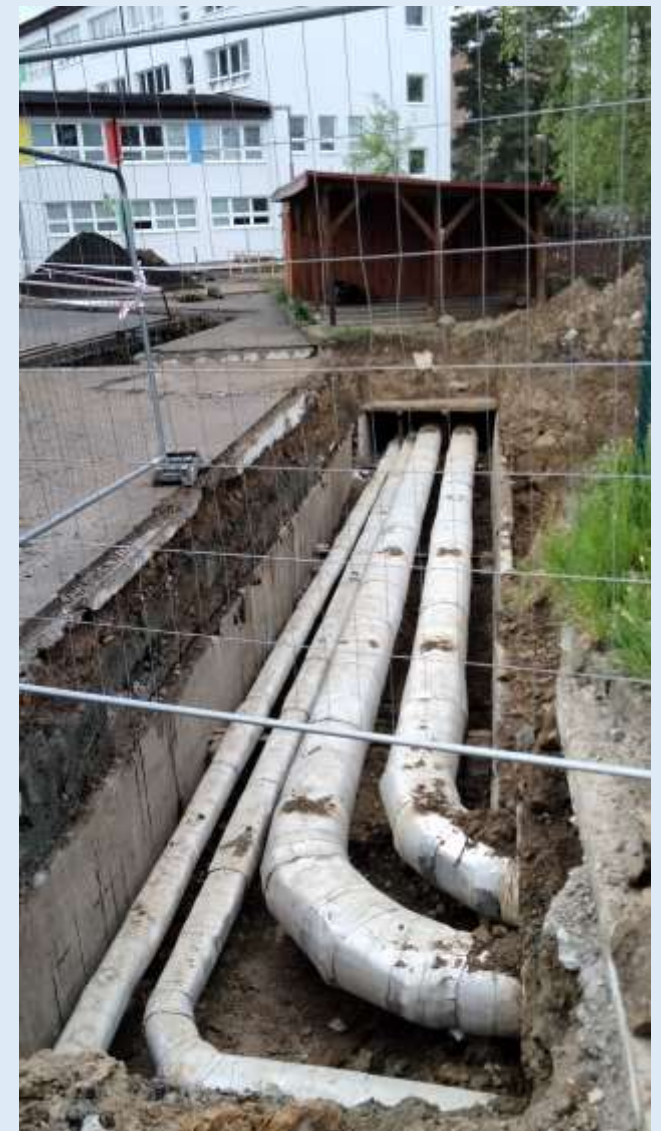
Pôvodné potrubie (výstup z kotolne K-04)
