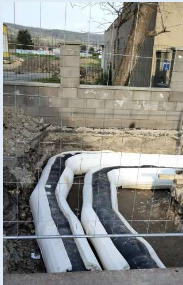
Aplikácia penových vložiek v miestach ohybu potrubia
