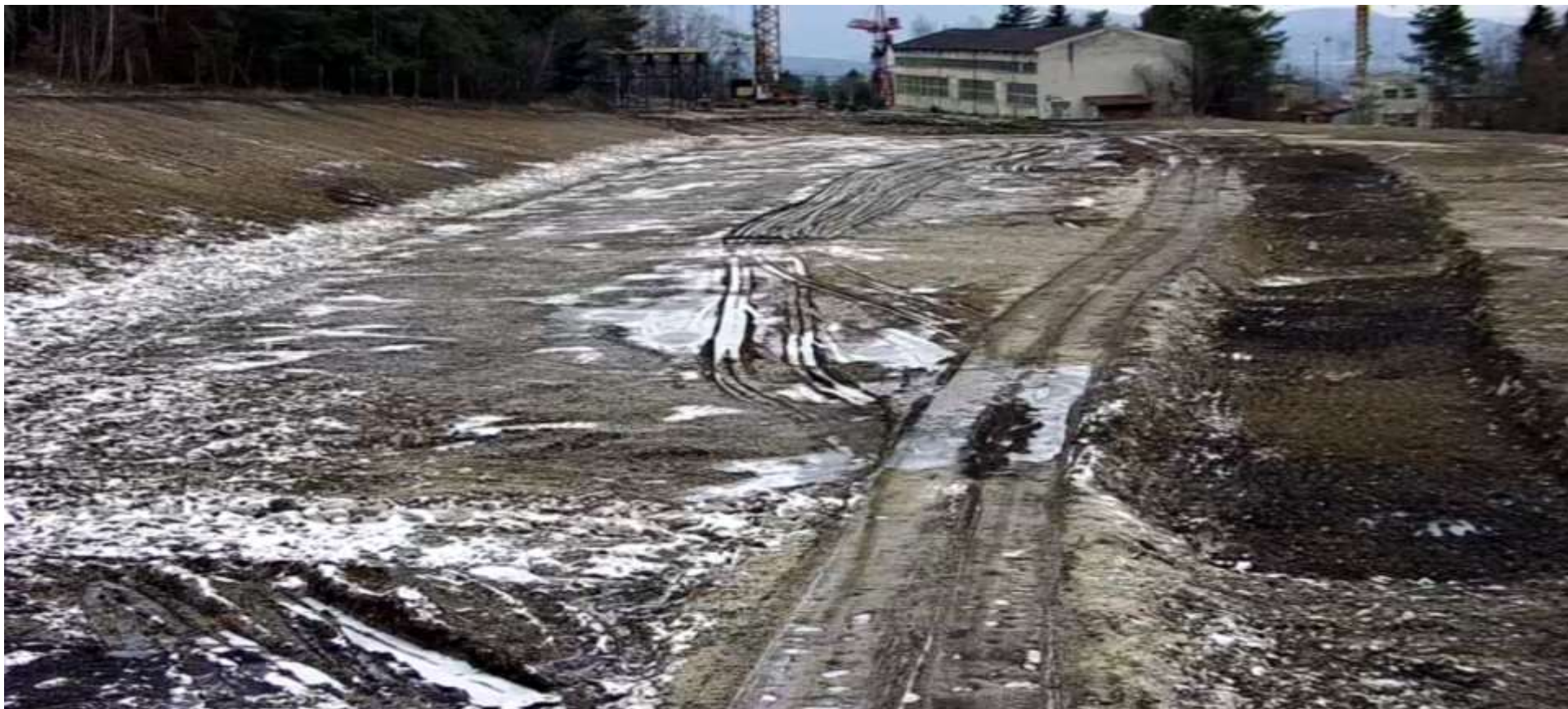
Príprava na inštaláciu tepelných čerpadiel, slnečných kolektorov a kogeneračnej jednotky.
