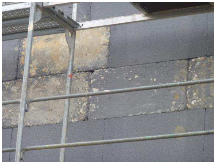
Nalepovanie poškodených TI dosiek
