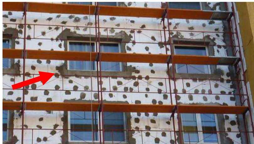
Správne použité diagonálne pásy výstužnej mriežky
