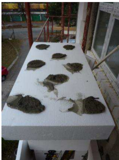
Lepenie TI dosiek iba na terče
