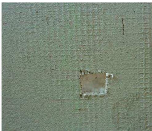
Lepenie TI dosiek iba na terče
