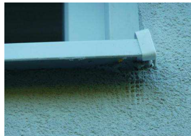
Nesprávne osadené rozp. kotvy
