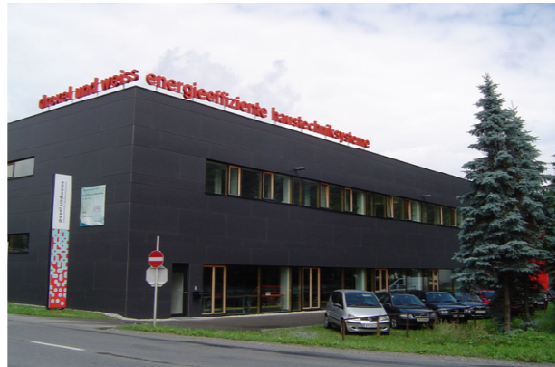
Administratívna budova firmy Drexel und Weiss, Wolfurt, Rakúsko
