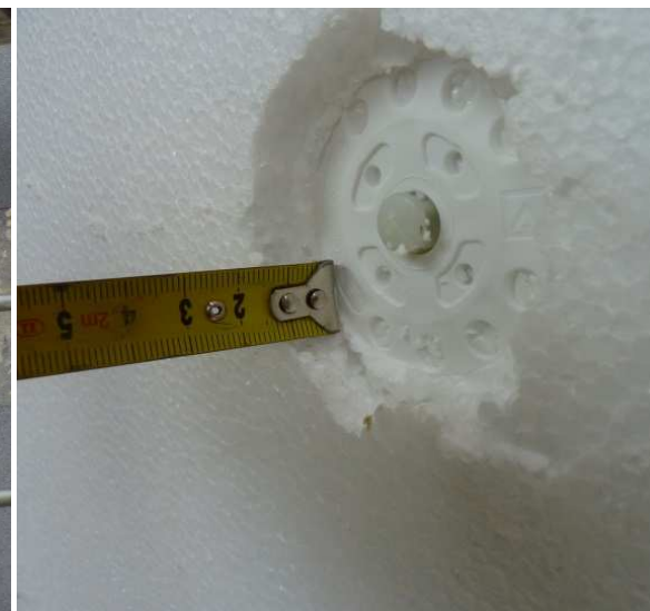
Nesprávne osadené rozp. kotvy
