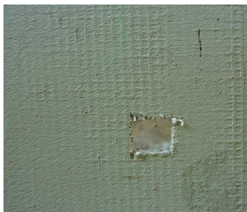
Lepenie TI dosiek iba na terče
