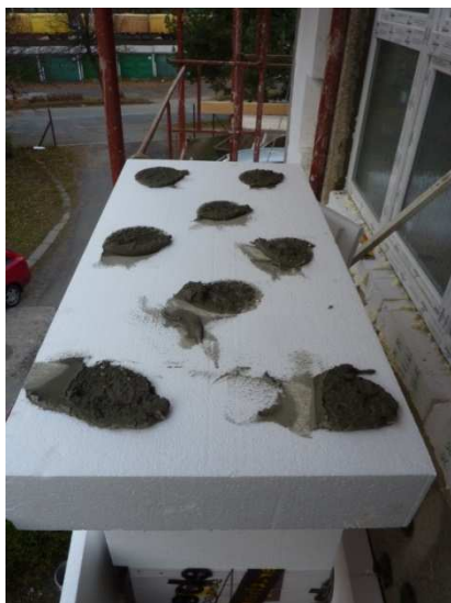
Lepenie TI dosiek iba na terče
