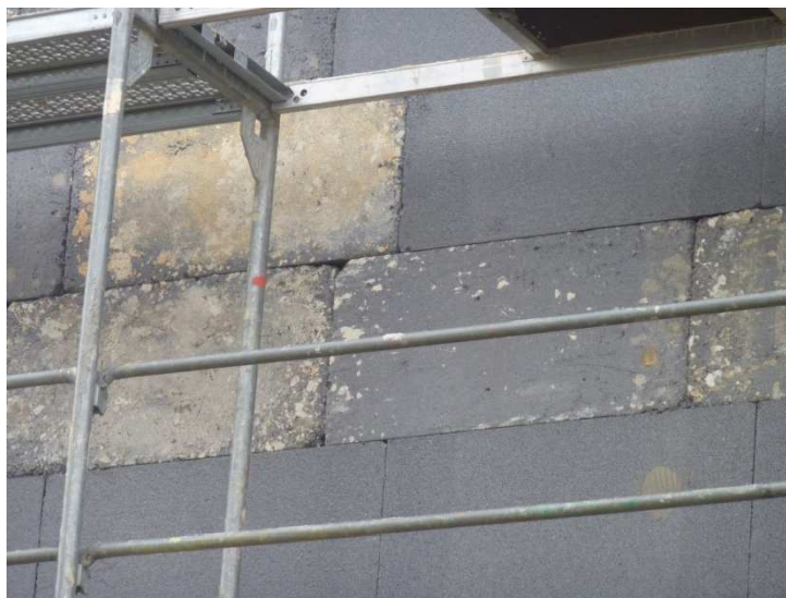
Nalepovanie poškodených TI dosiek
