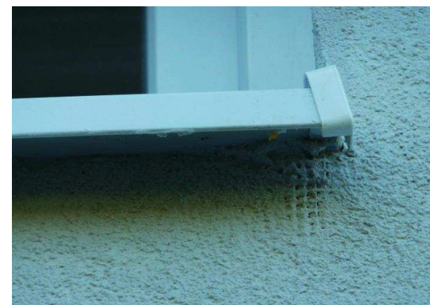
Nesprávne osadené rozp. kotvy
