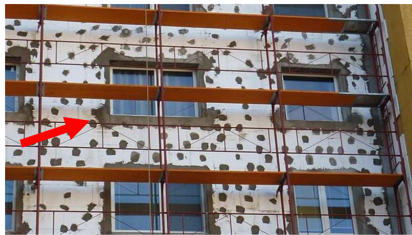
Správne použité diagonálne pásy výstužnej mriežky
