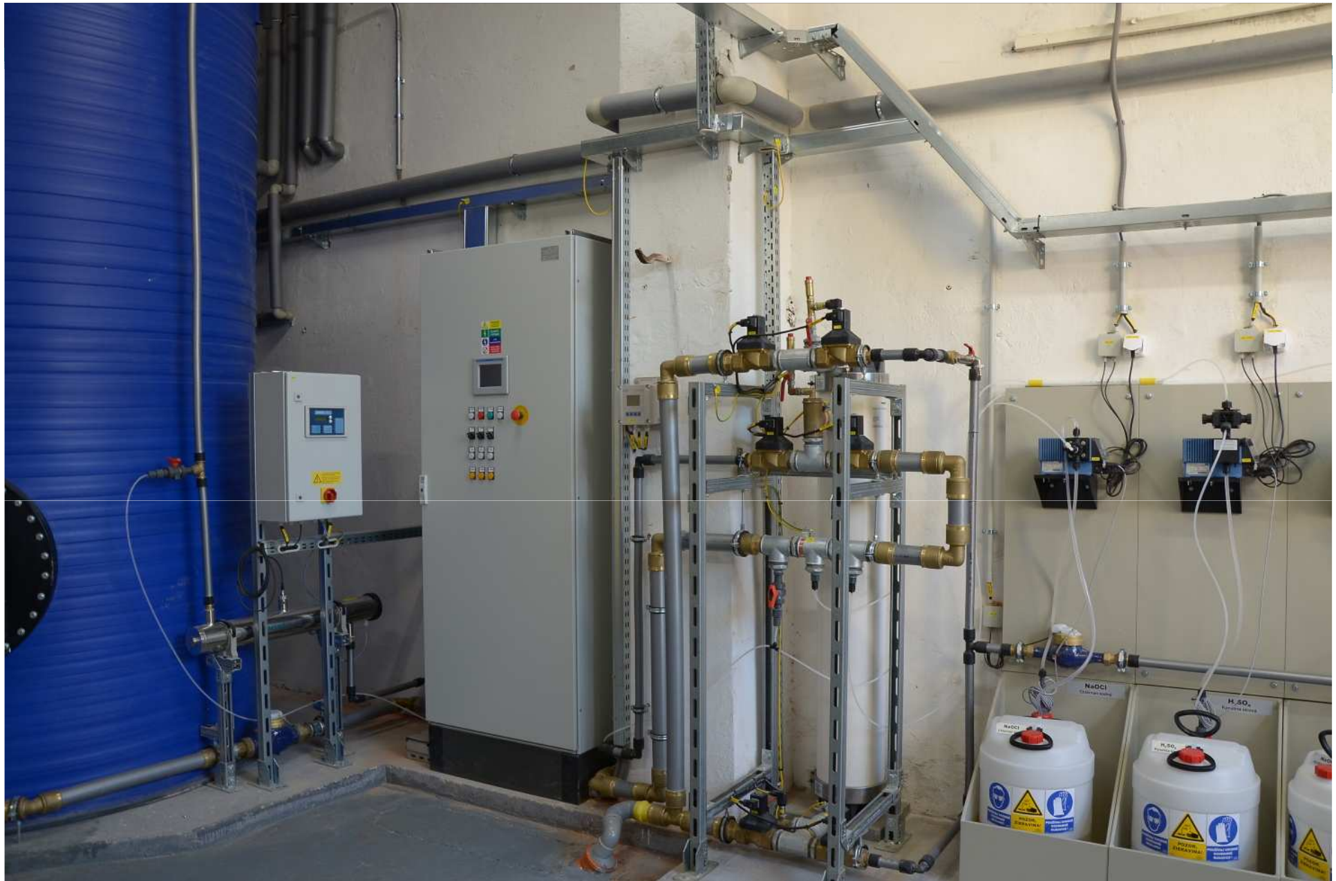
Nová úpravňa vody
