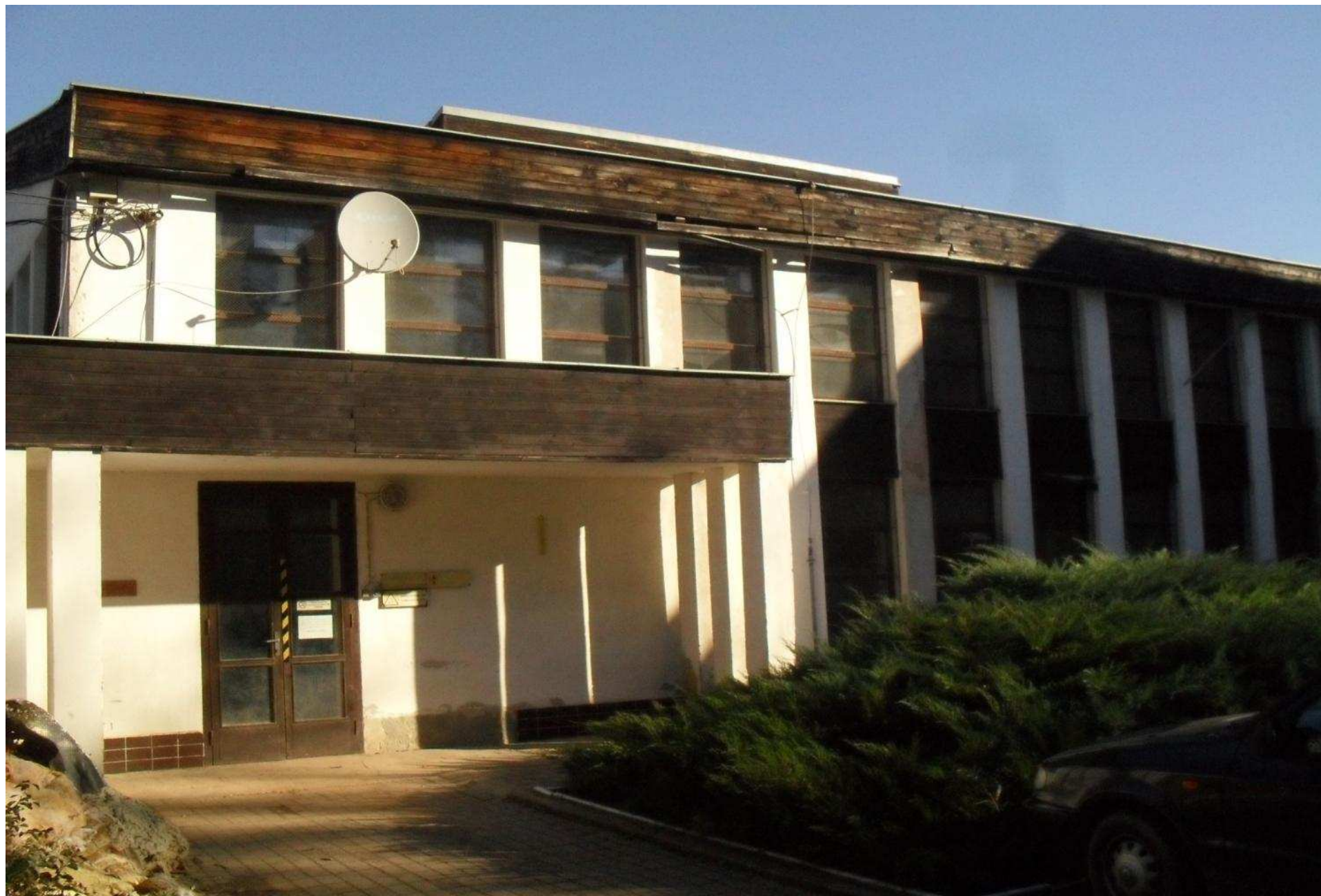
Objekt starej kotelne
