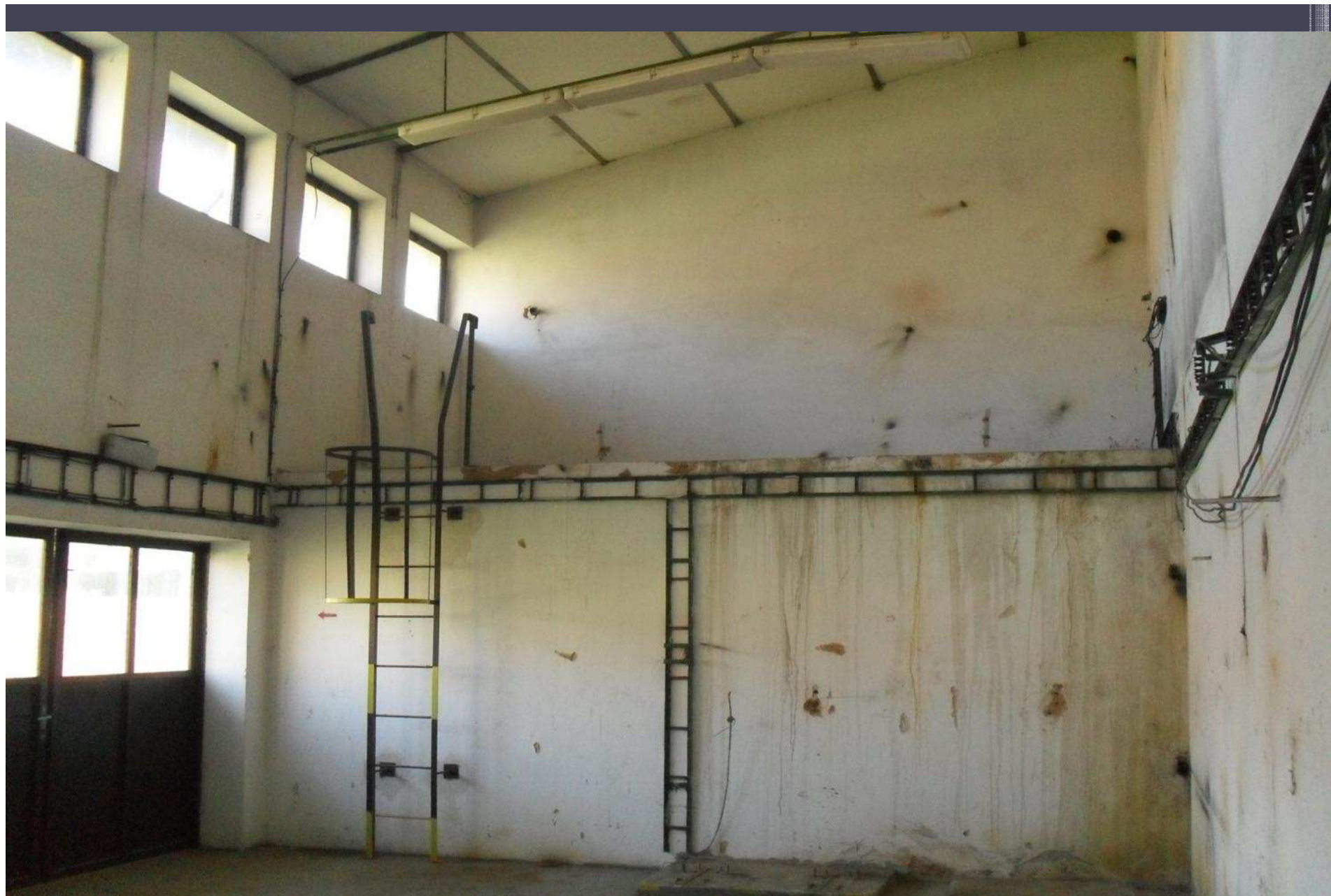
Interiér starej kotolne po demontáži
