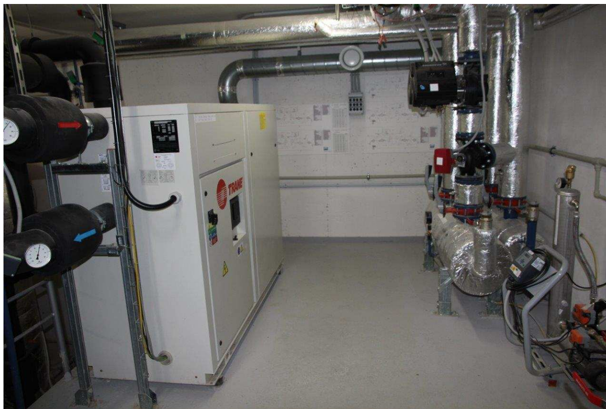
Tepelné čerpadlá zem – voda (výkon 2 x 95 kW)
