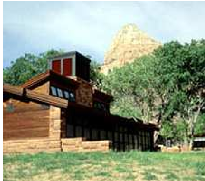
Zion National Park – návštevnícke centrum s odťahom vetracieho vzduchu cez vysoko položené okná a „nástav- com“ s odparovacím chladením (foto Robb Williamson)
