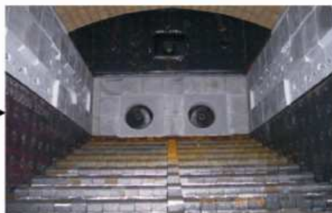
Spaľovacia komora biomasového kotla
