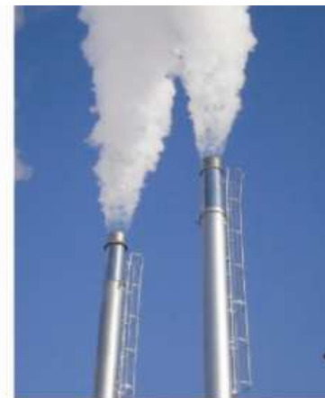
Výstup na komínoch
