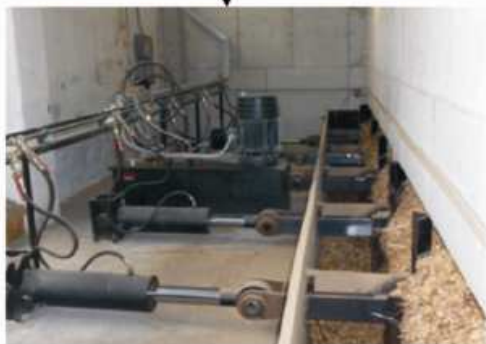
Doprava paliva do biomasového kotla
