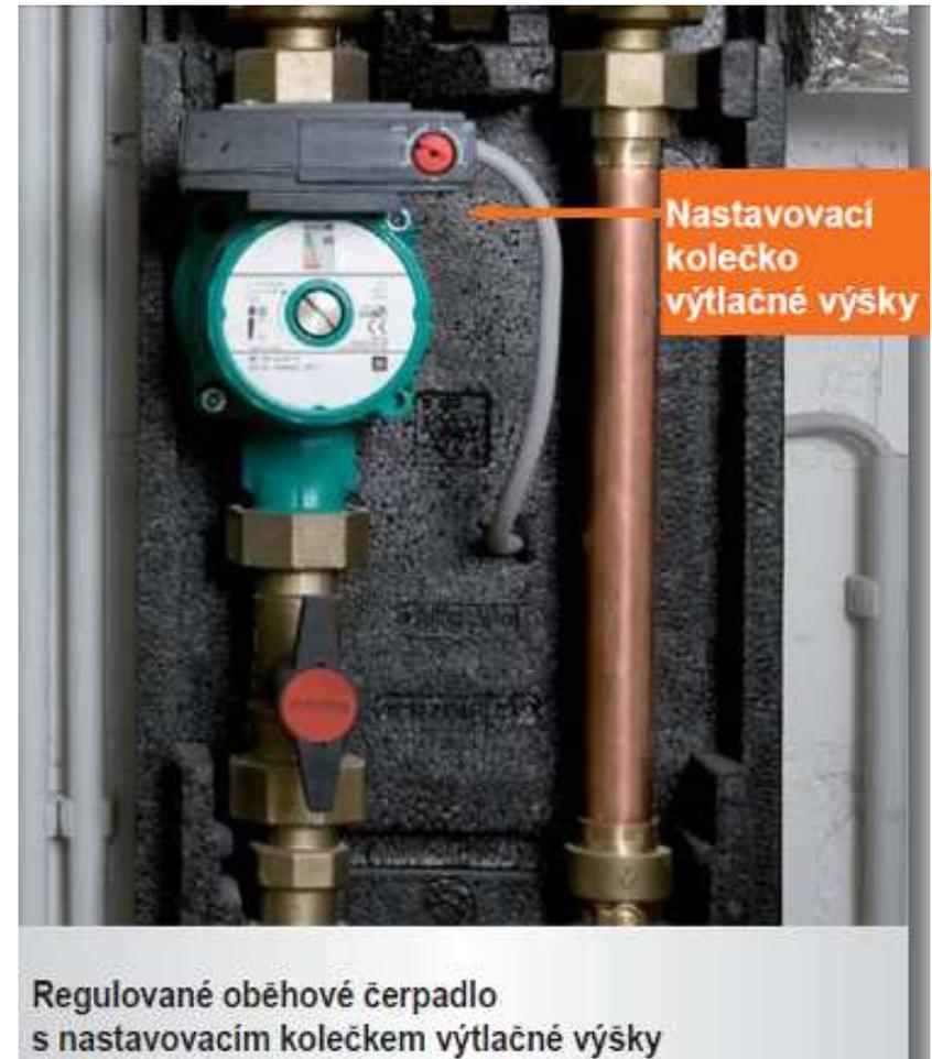
Regulované obehové čerpadlo s nastavovacím kolečkom výtláčnej výšky
