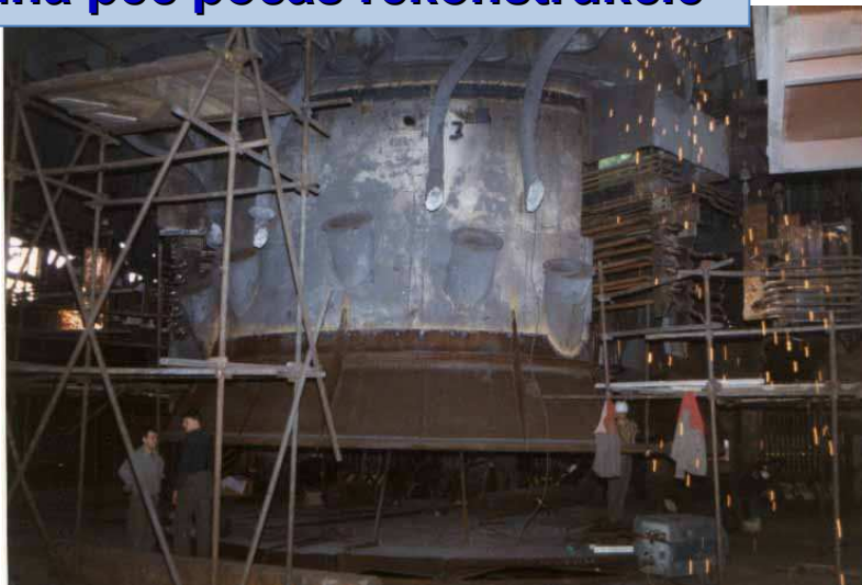
Pôvodná pec počas rekonštrukcie
