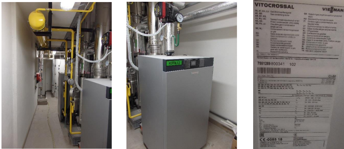
Obrázok 9: Kotelňa s kondenzačným kotlom na zemný plyn
