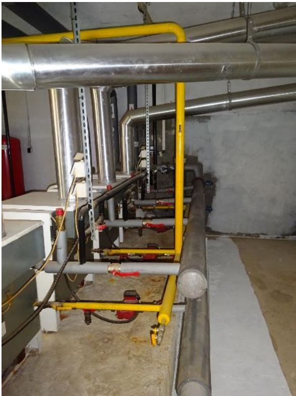
Obrázok 20 - Priestor pre inštaláciu merania spotreby plynu
