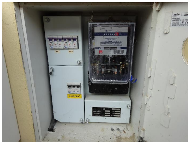
Obrázok 19 – Fakturačný elektromer s hlavným rozvádzačom. Priestor pre inštaláciu merania.
