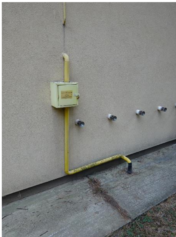
Obrázok 2 – Priestor pre inštaláciu merania spotreby plynu pre pavilón B
