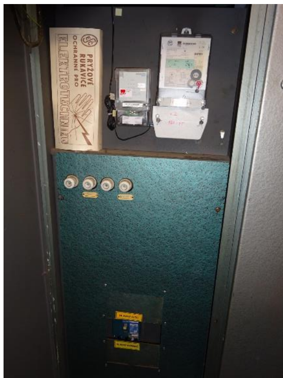
Obrázok 13 – Priestor pre inštaláciu merania spotreby EE – fakturačné meradlo (3F)
