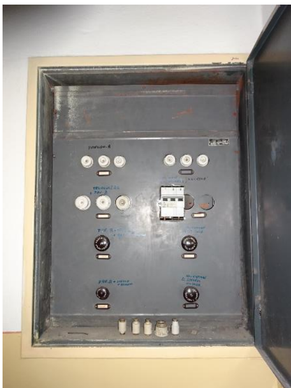
Obrázok 3 – Hlavný rozvádzač (3F). Priestor pre inštaláciu merania elektrickej energie
