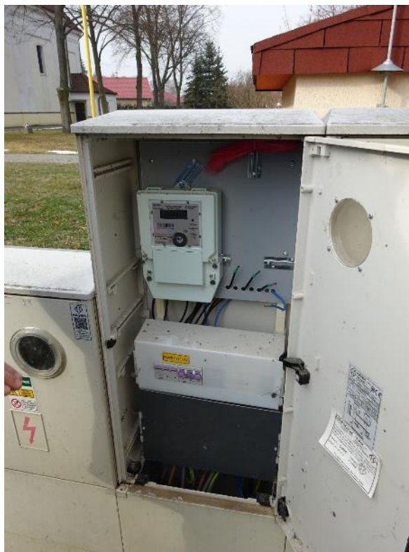
Obrázok 8 – Priestor pre inštaláciu merania spotreby EE – fakturačné meradlo (3F)
