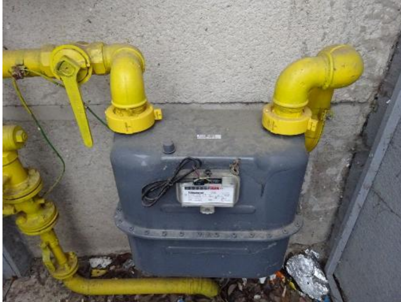
Obrázok 14 – Fakturačný plynomer G10
