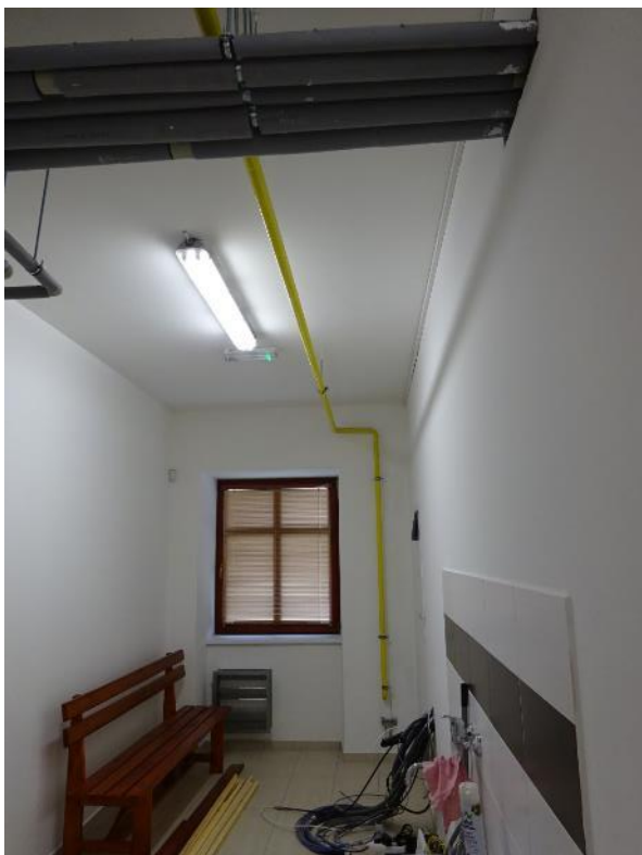
Obrázok 7 - Priestor pre inštaláciu merania spotreby plynu
