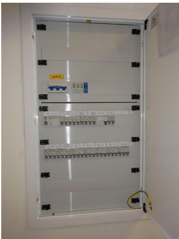
Obrázok 9 – Hlavný rozvádzač pre prvé podlažie
