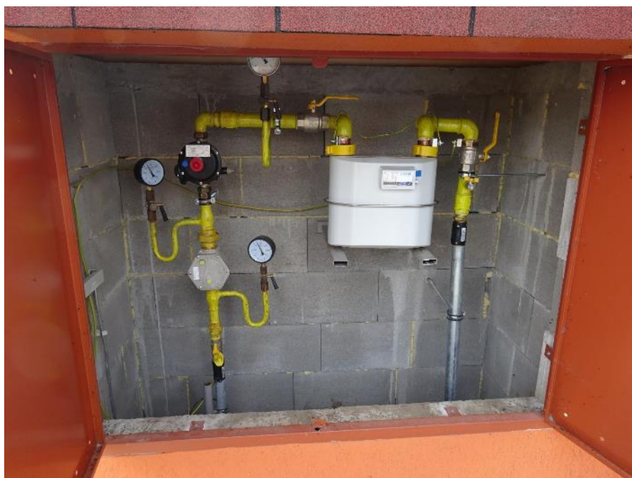
Obrázok 11 – Fakturačný plynomer G10
