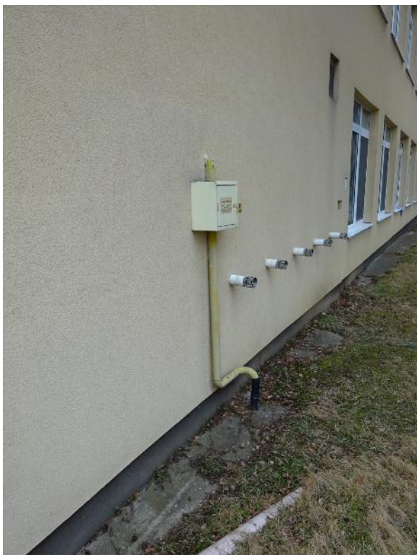
Obrázok 1 - Priestor pre inštaláciu merania spotreby plynu pre pavilón A
