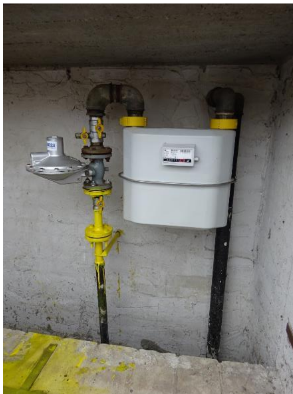
Obrázok 16 – Fakturačný plynomer G10
