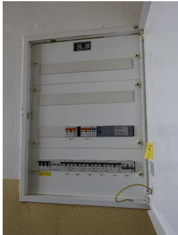
Obrázok 21 – Hlavný rozvádzač . Priestor pre inštaláciu merania spotreby EE
