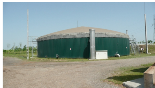
Biogas plant in Kecskemét at Pilze-Nagy Ltd.
