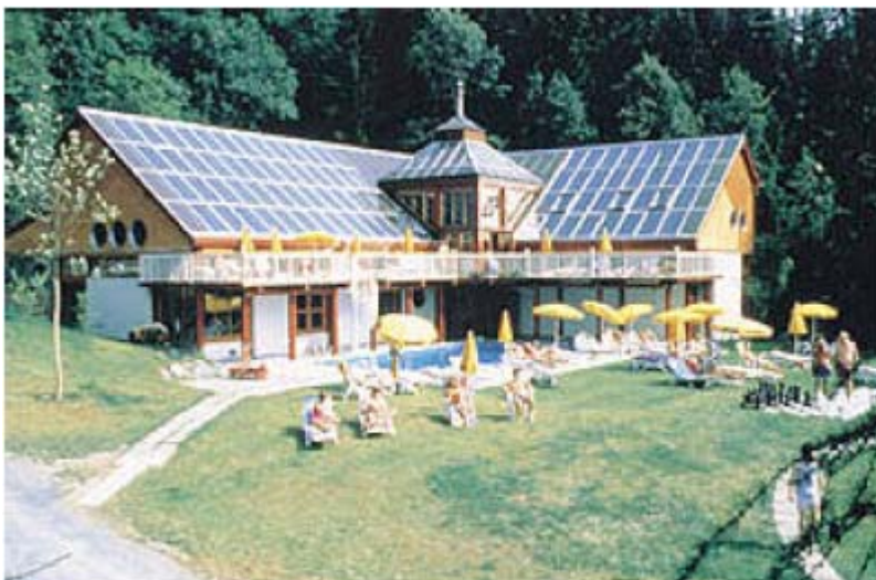
Solárne kolektory integrované do strechy (zdroj: AIE)
