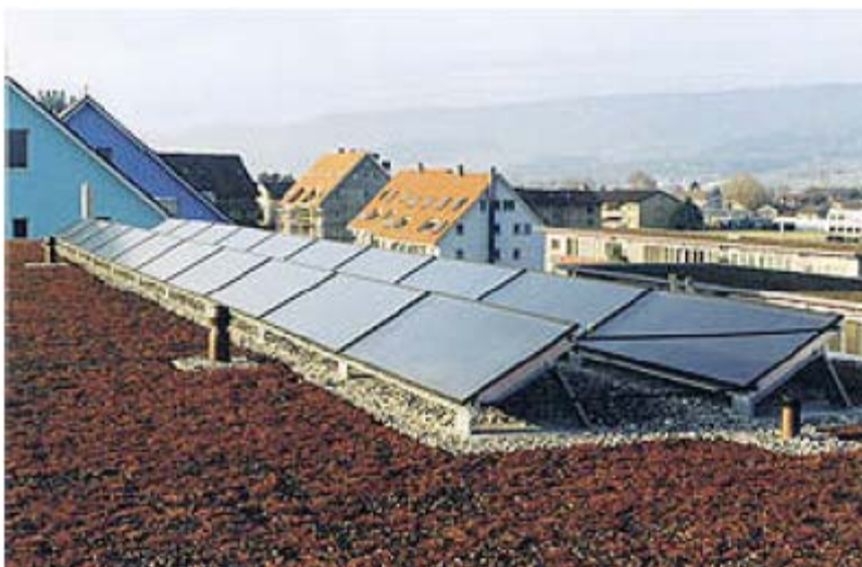
Samostatne nesené kolektory na rovnej streche
