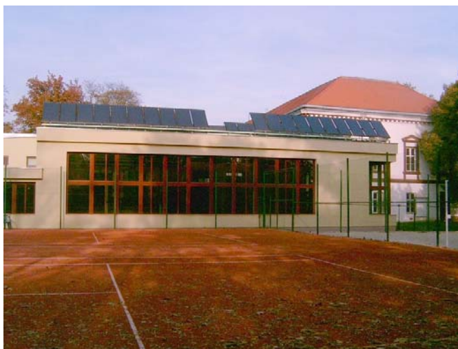
Obr. 4: Miesto: Mojmírovce - Zámok / hotel Ohrievanie vody pre krytý bazén a príprava teplej vody pre sprchy
